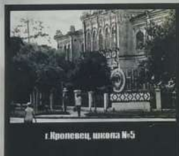
Главный корпус школы, где учился И.В. Ковдя
